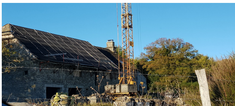
Rénovation d'une toiture à Hautefage
