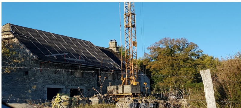
Rénovation d'une toiture à Hautefage
