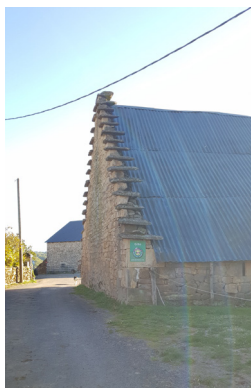
Pignon à pas d'oiseau, Saint-Cirgues-de-la-Loutre
