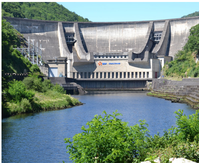
Barrage du Chastang Crédits : Cittanova
