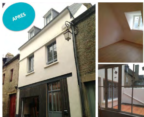
Chantier-pilote suivi par l'EPF Bretagne, Josselin (56)
