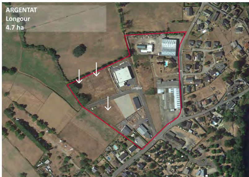
Derniers aménagements (PC) sur le site du Longour, Argentat sur Dordogne.
