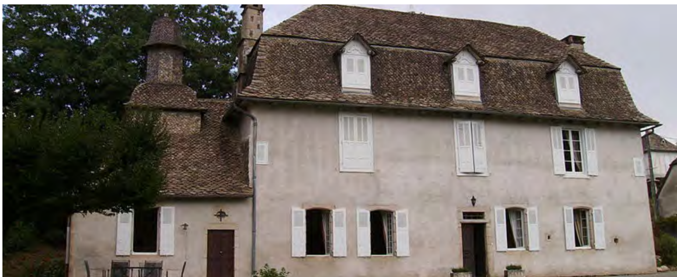
Château du Bac à Argentat, Classement des façades et toitures du château et son colombier - Source: monumentum.fr
