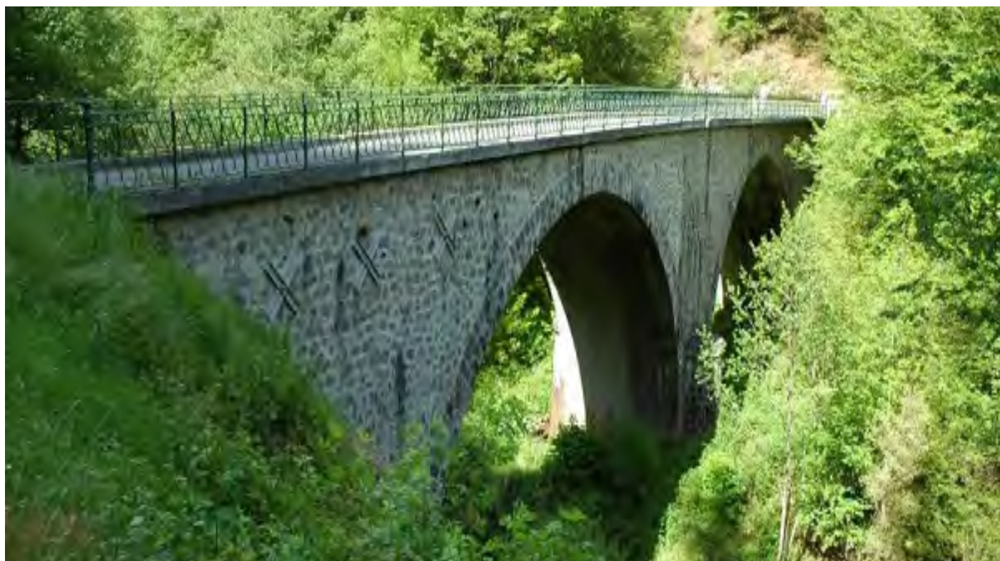
Pont de la Maronne, liaison entre le Cantal et la Corrèze à Saint-Cirgues-la-Loutre Source: Structurae
