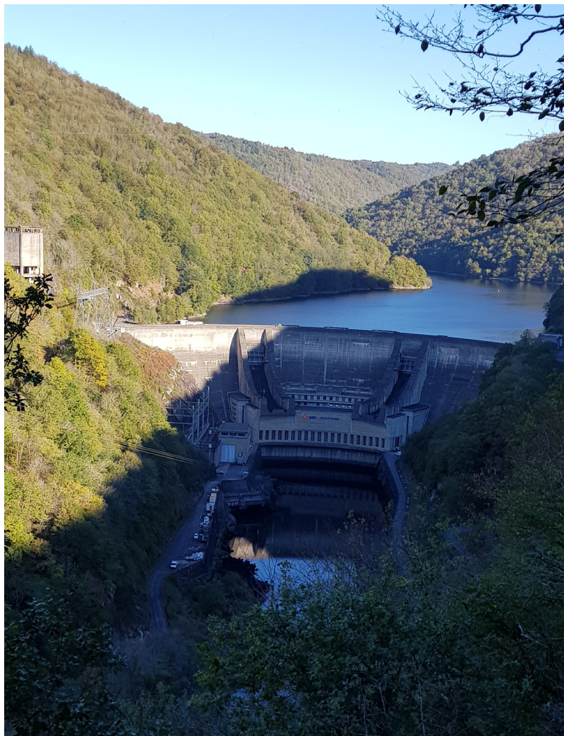
Conforter et entretenir les sites de production hydro-électrique sur le territoire.
