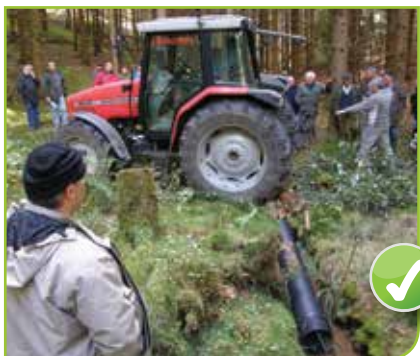
Tube PEHD* recouvert de rondins
