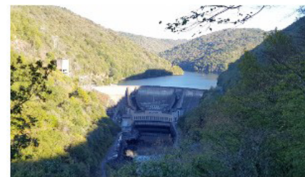
Barrage du Chastang, en amont d'Argentat Crédits : Cittanova
