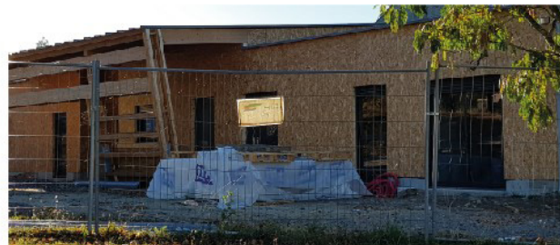
Extension de l'EPDA, Servièrès-le-Château
